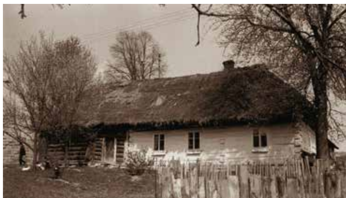
Binarowa (powiat gorlicki), chałupa zrębowa z amfiladowym układem izb, dach czterospadowy. Część mieszkalna bielona, gospodarcza z pasami na styku belek, fot. H. Olszański 1975 r.
